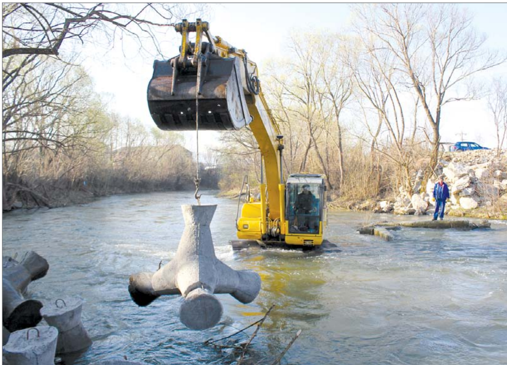
Kövekkel és betonlapokkal igyekeznek visszatérlni a folyót medrébe
