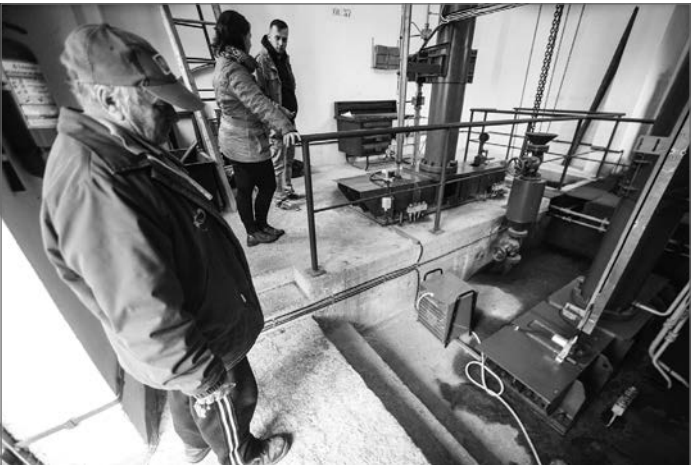
Elektromosan és kézi erővel is működtethetők a zsilipek
