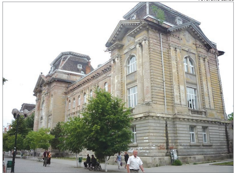
Felújításra szorul a beregszászi főiskola épülete is
